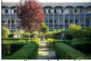
nouvelle entrée face à la cour d'honneur
