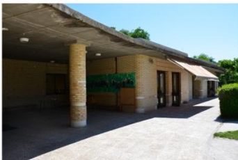
Ecole de la maternelle du bas (bâtiment M)
